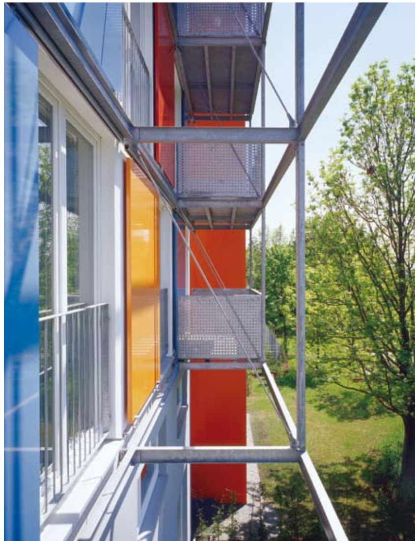
Stahlkonstruktion mit Balkonen
