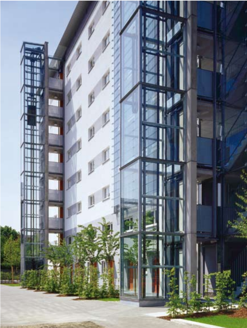
Aufzugsanlage mit Treppenhäusern im Osten
