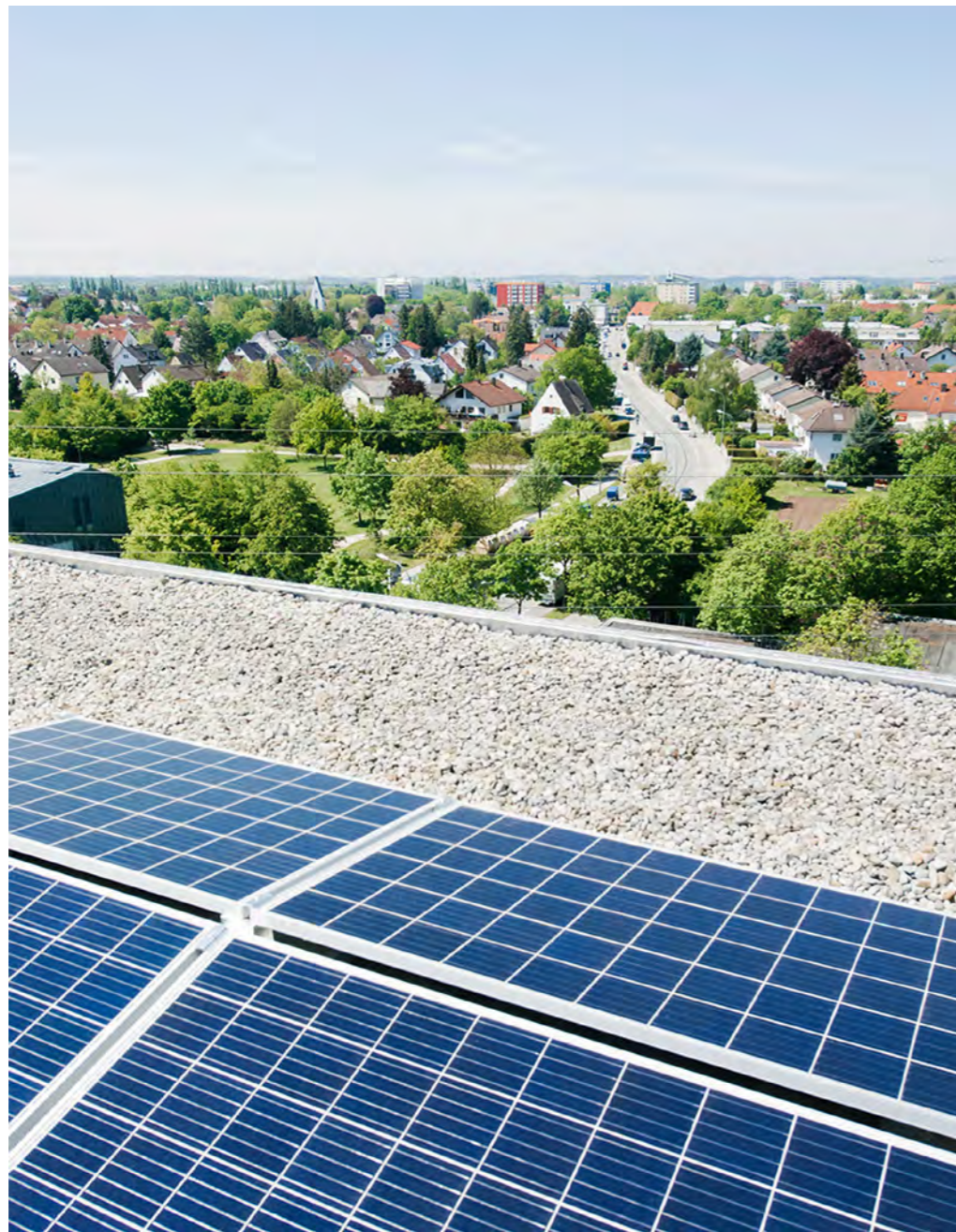
Gebäudemodernisierung an der Radolfzeller Straße
